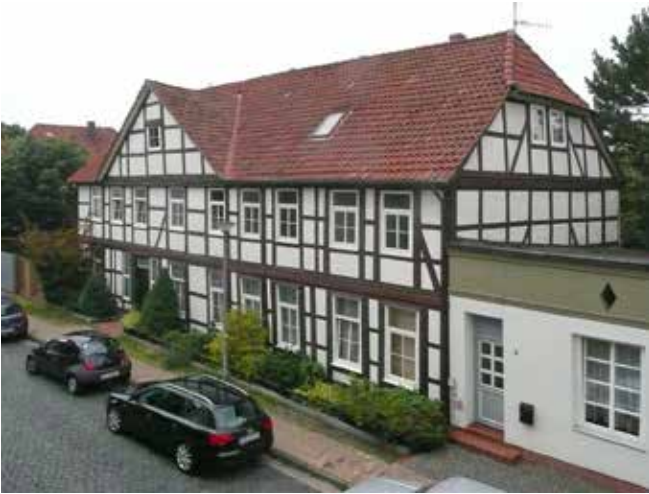
Ohagenstraße 7, 2010 (Foto: Rüsche).
