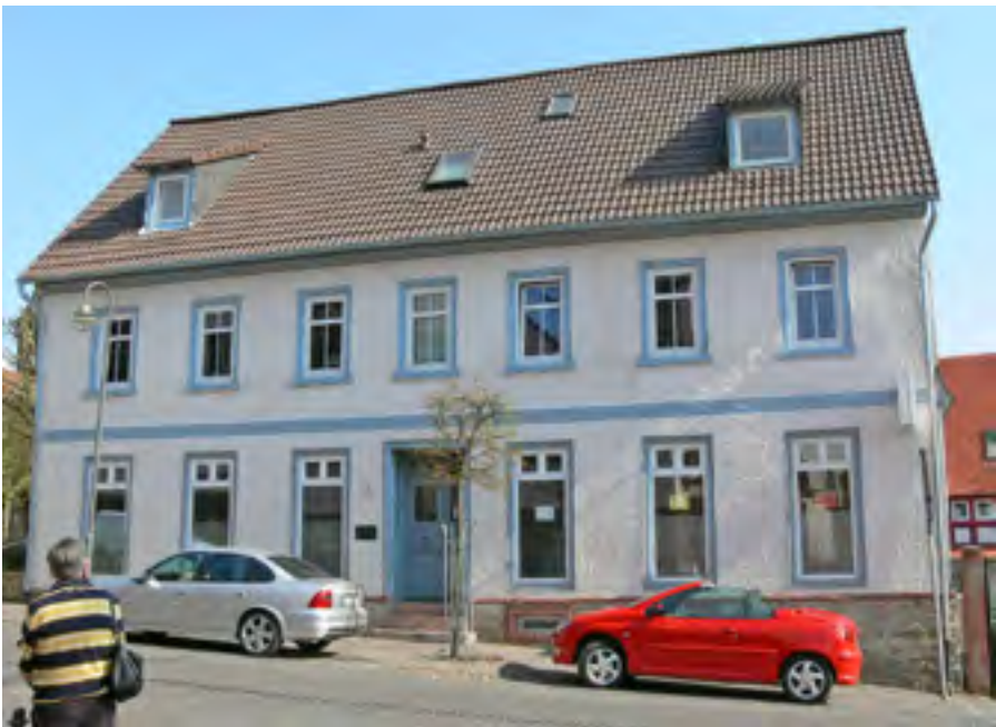
Strumpf- und Flanellfabrikant Jacques Gauterin erbaute das Haus Hugenottenstraße 111, in dem von 1870 bis 1914 eine Lohgerberei betrieben wurde.
