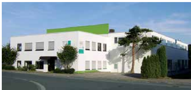
Das Firmengebäude der Garnier GmbH in Friedrichsdorf, Otto-Hahn-Straße 16.
